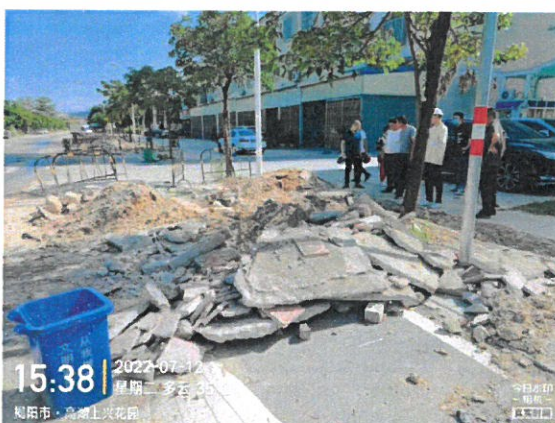
929 乡道现场勘查
