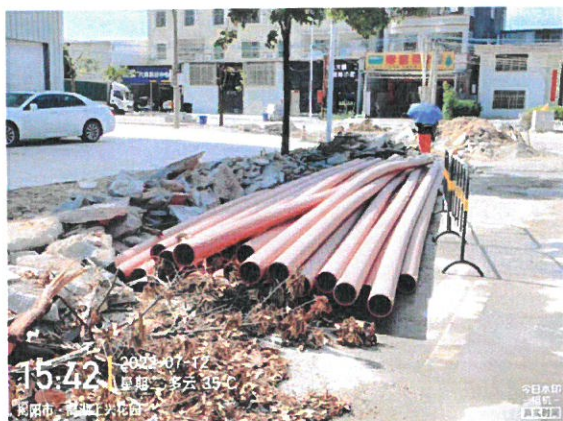
929 乡道现场勘查
