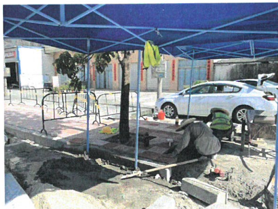
沿堤路现场勘查
