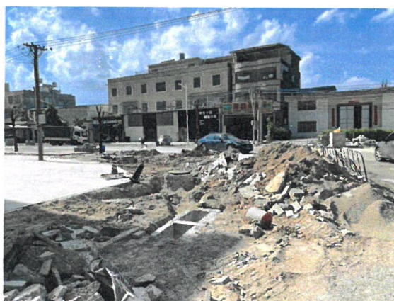
沿堤路现场勘查
