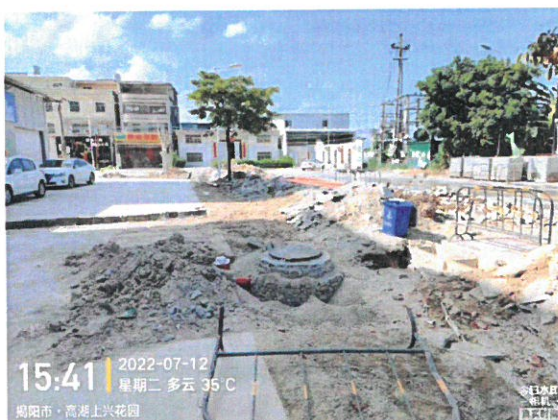
929 乡道现场勘查
