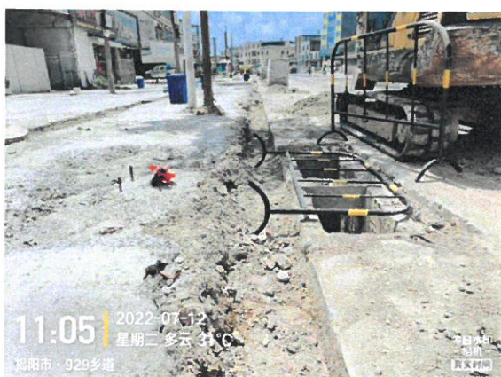
929 乡道现场勘查
