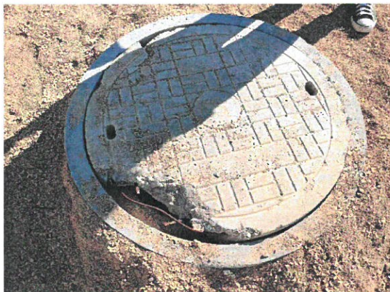
溪西镇院前村现场勘查
