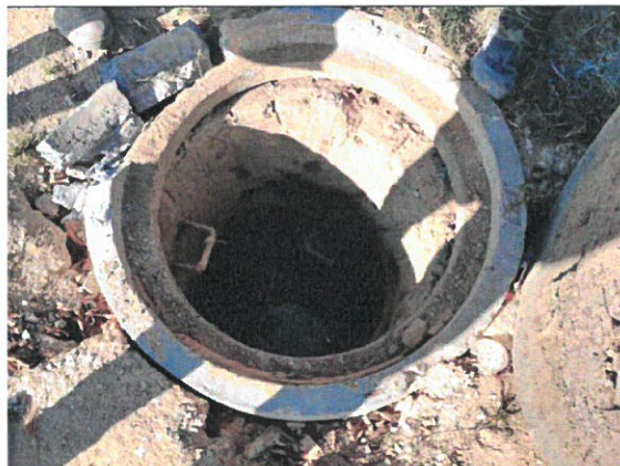
溪西镇院前村现场勘查
