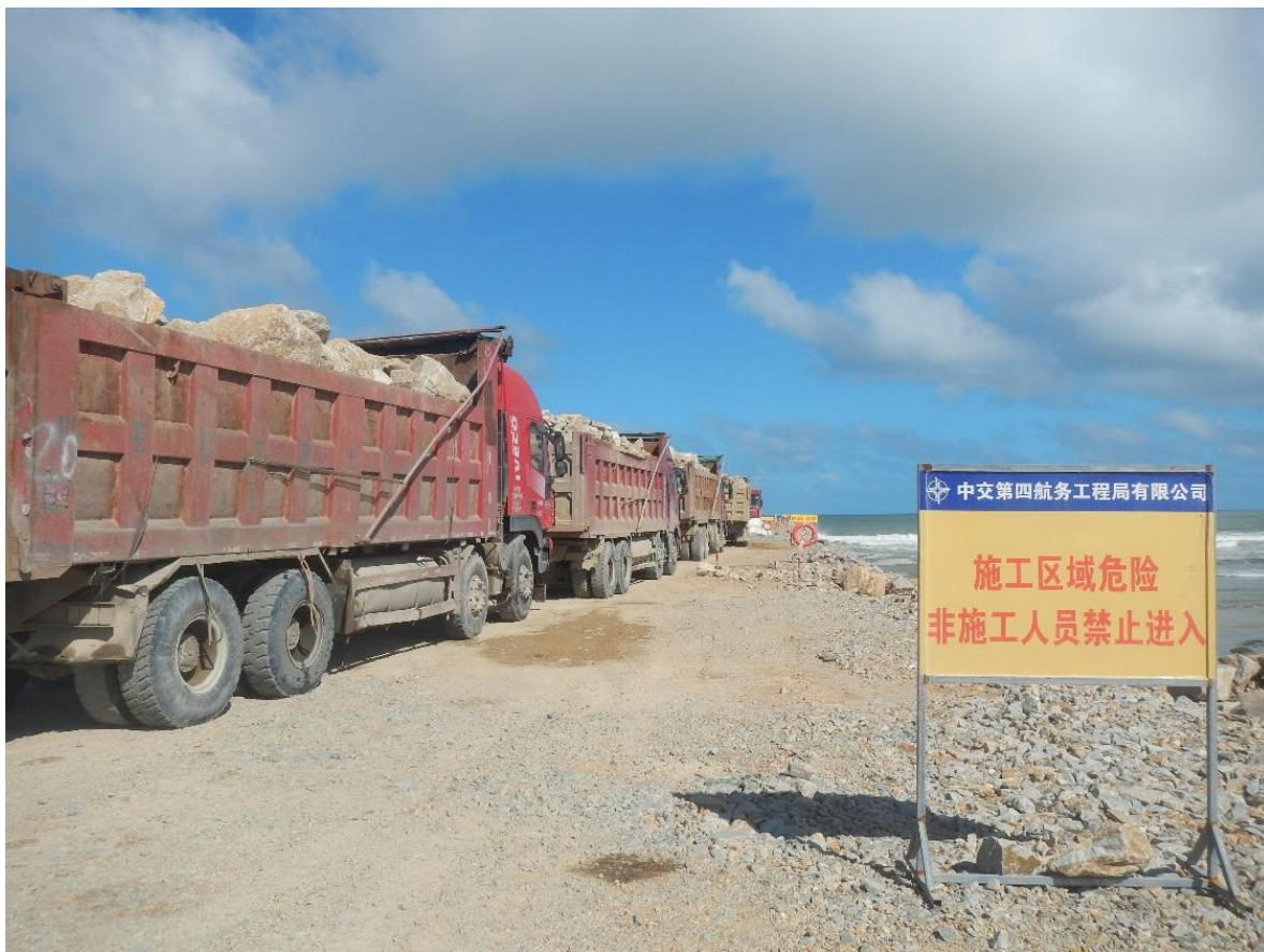
图 3.4.2-5 项目东侧东防波堤工程施工现场
