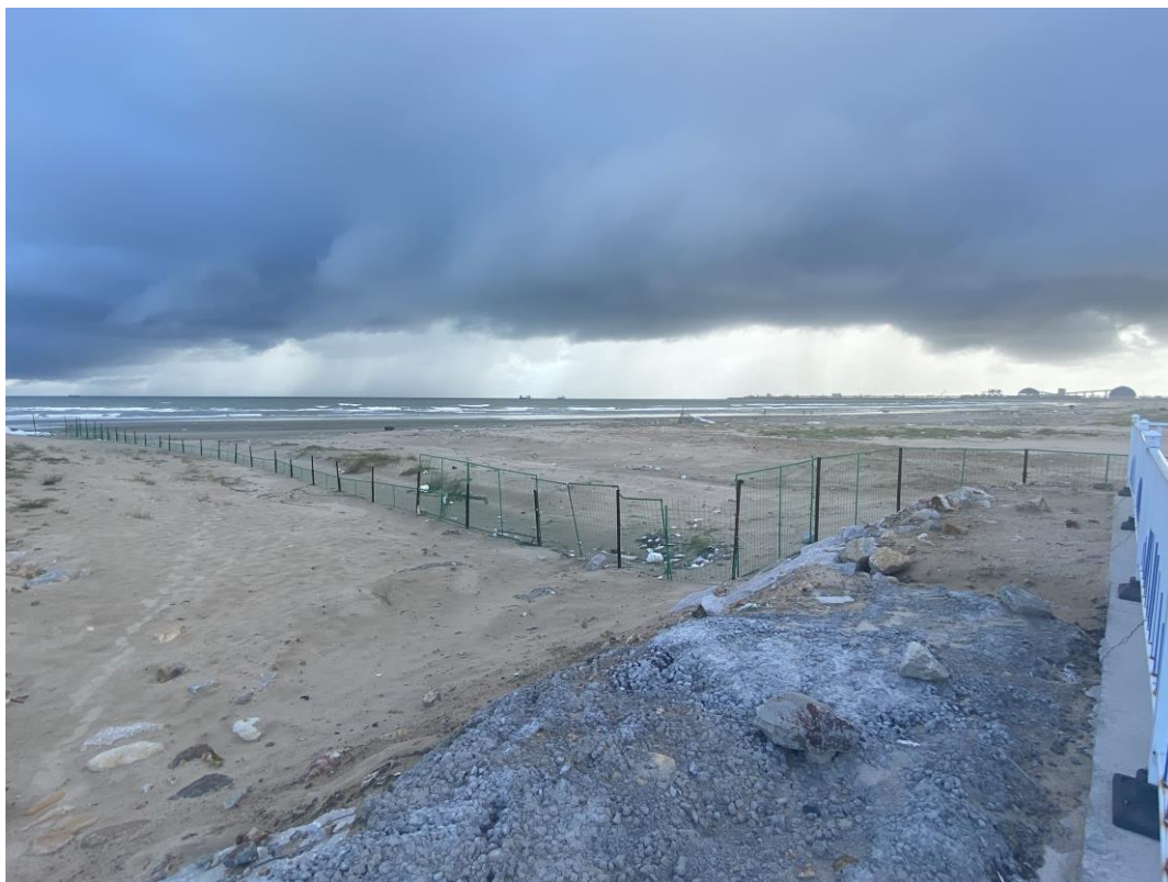
图 7.1.2-4 东防波堤工程现状建设情况（拍摄时间：2022 年 8 月）
