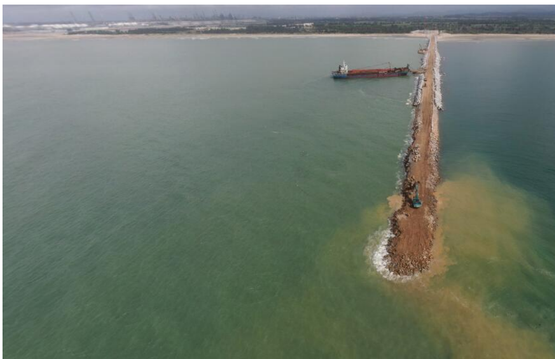
图 7.1.2-1 码头东侧东防波堤工程现状建设情况（拍摄时间：2022 年 6 月）
