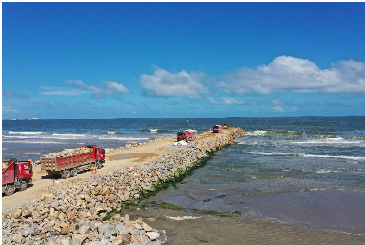
图 3.4.2-4 项目东侧东防波堤工程（在建）
