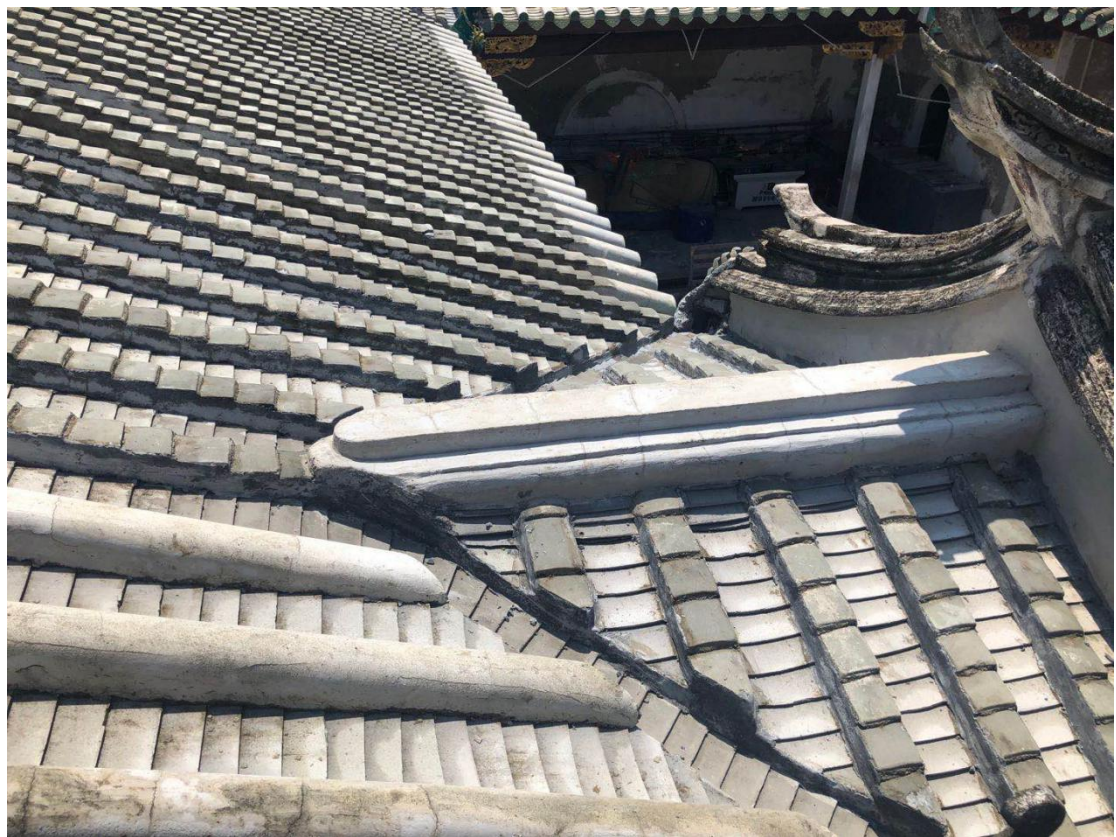
瓦屋面修缮后
