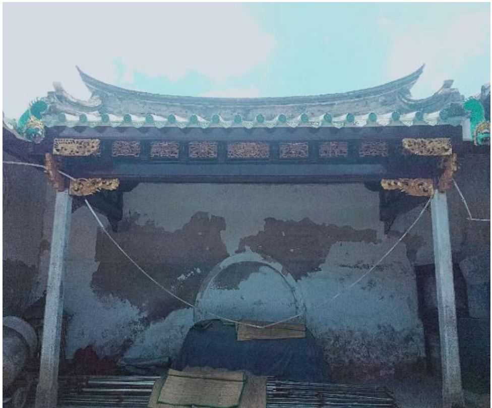
一进连廊修缮后
