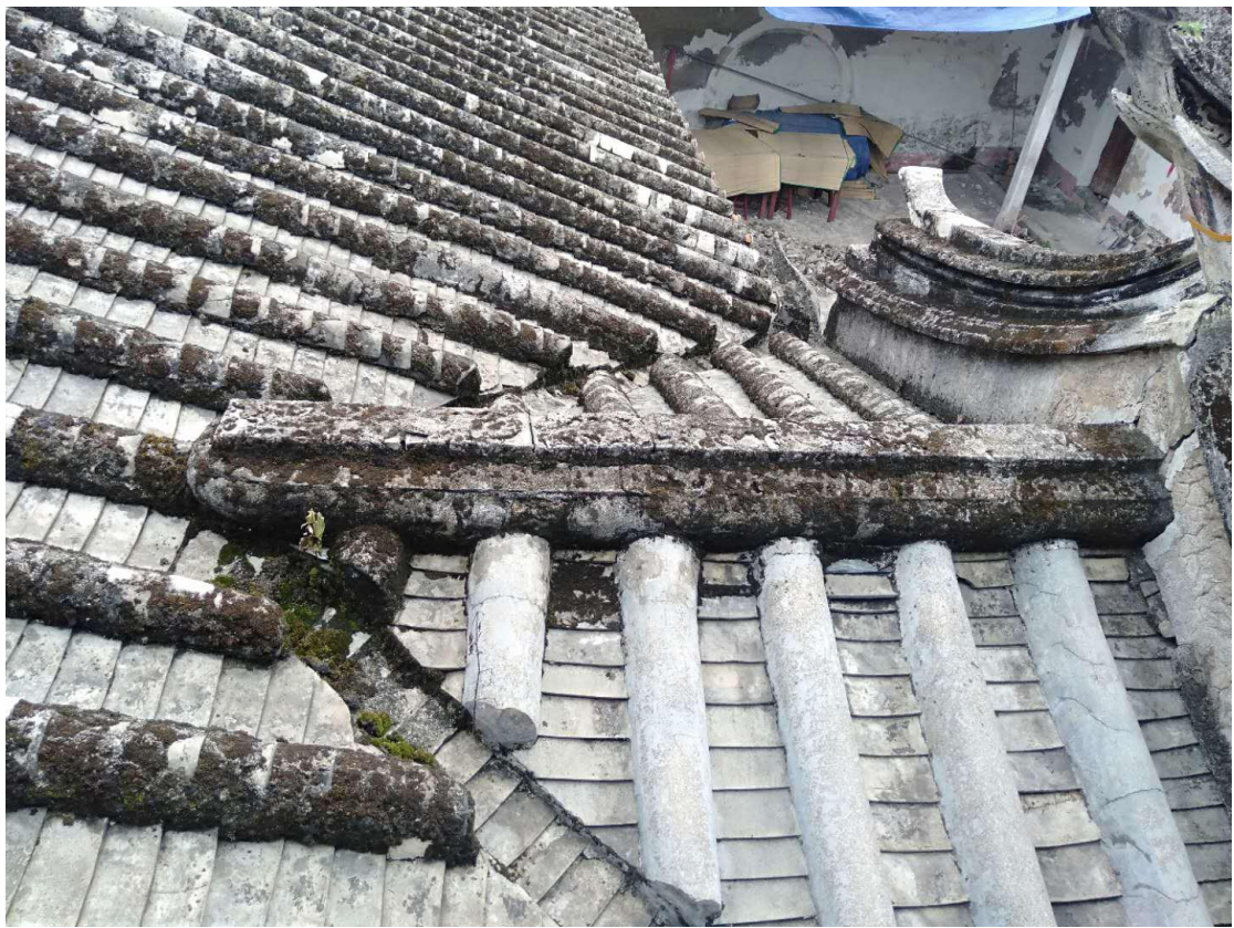
屋面瓦修缮前
