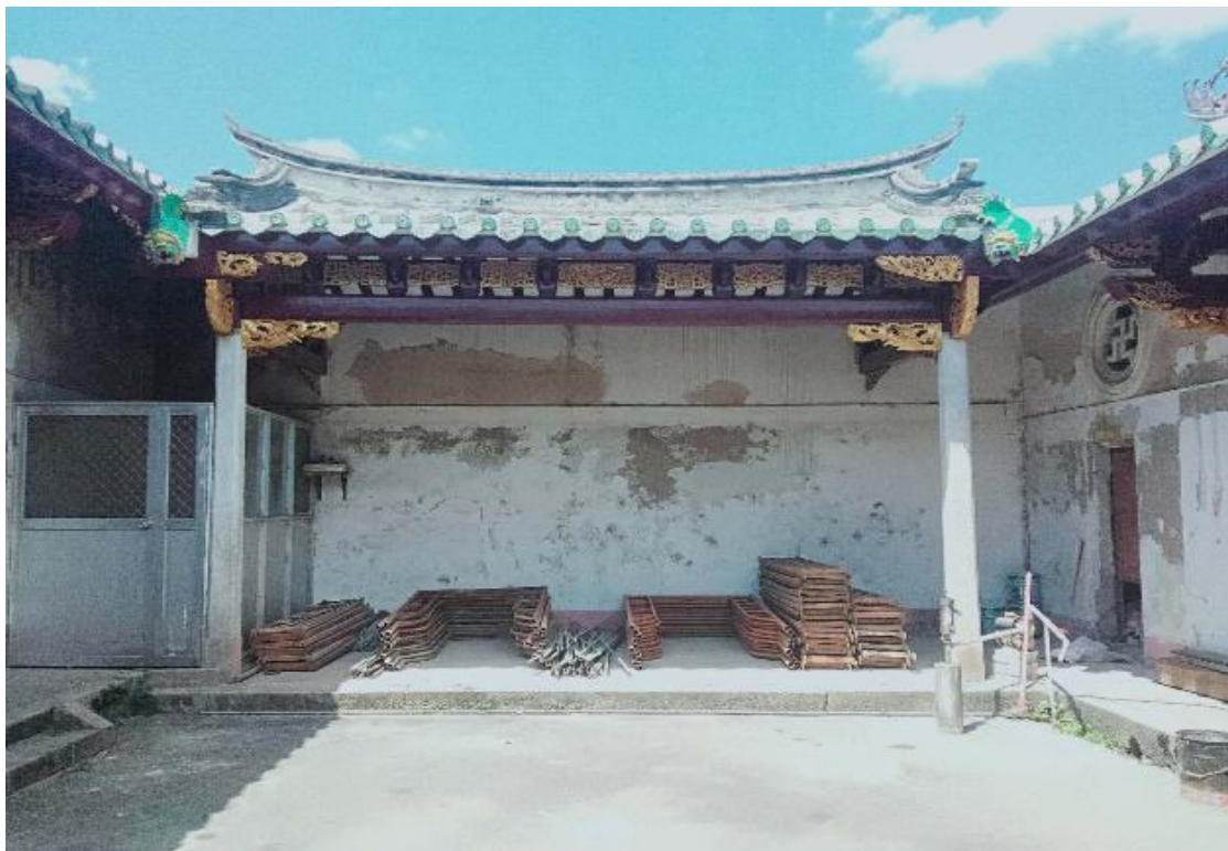
一进连廊修缮后
