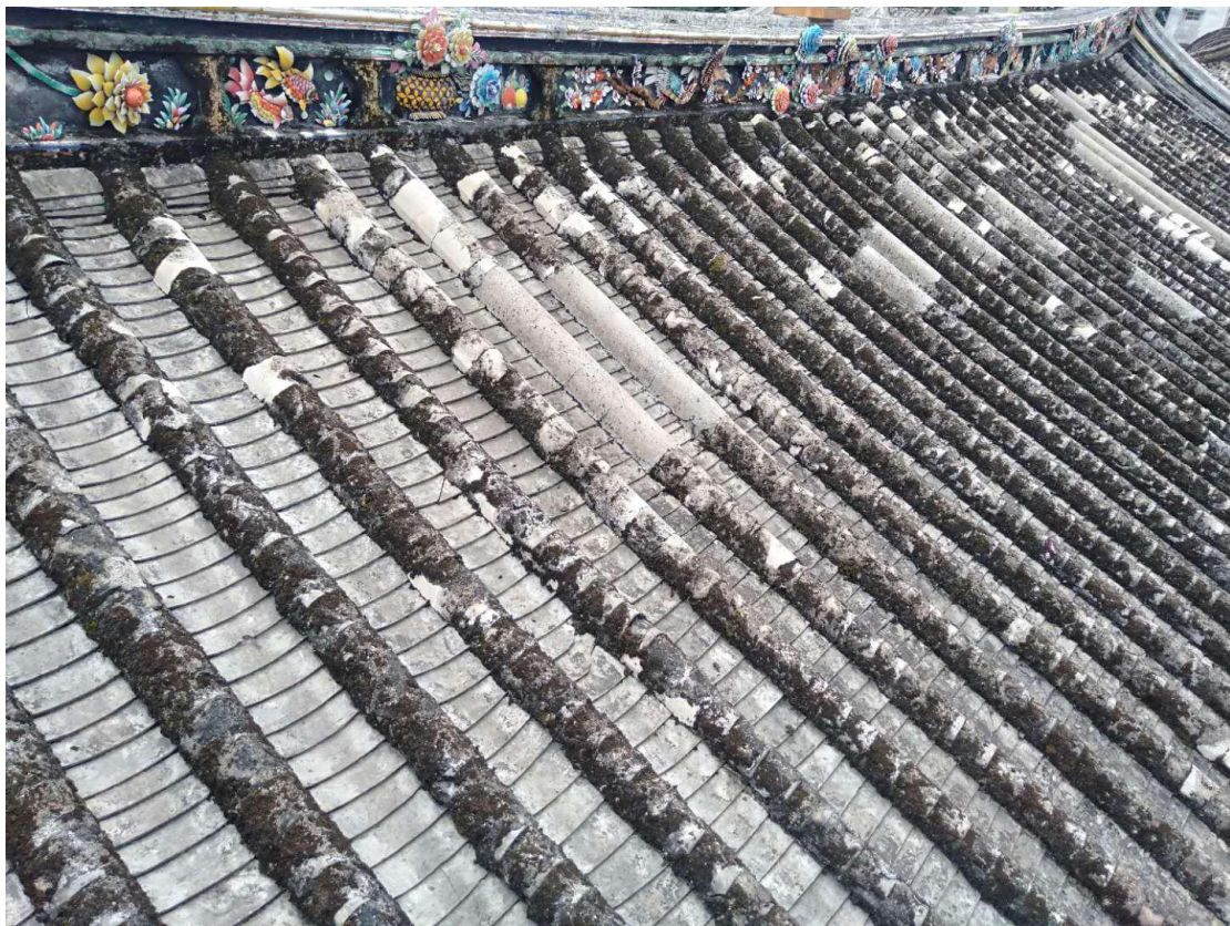
屋面瓦修缮前
