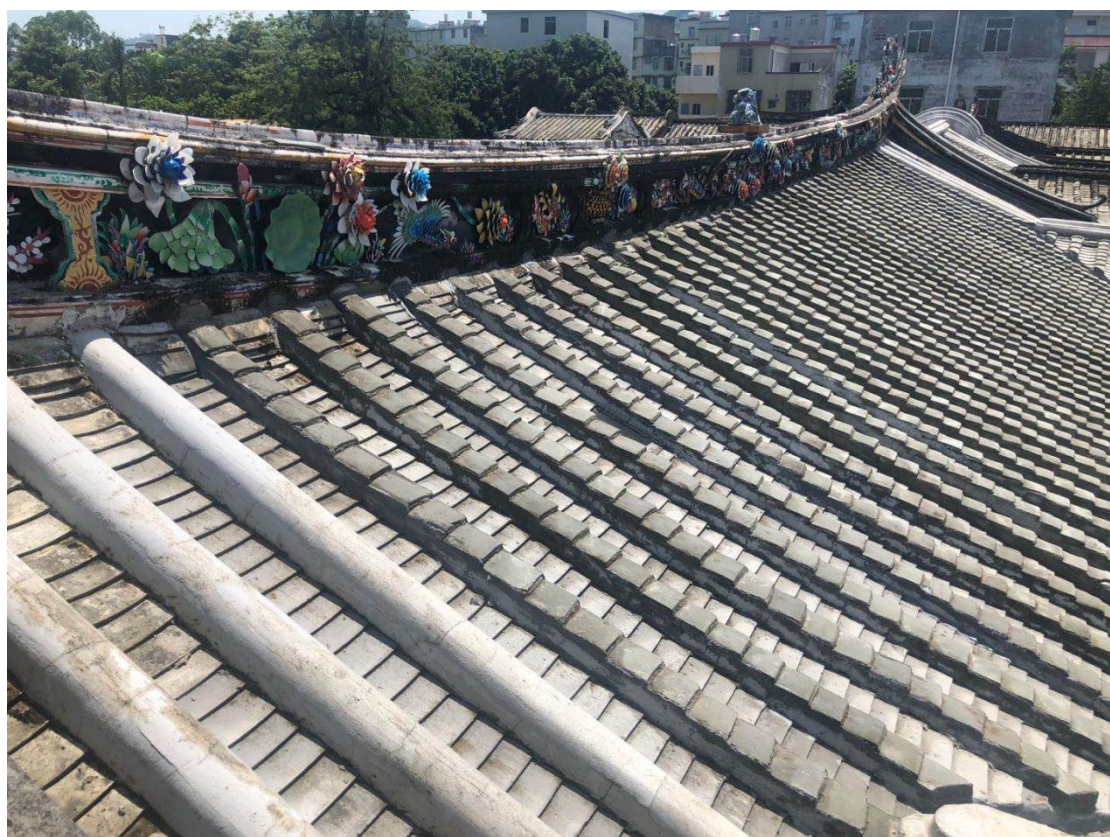
瓦屋面修缮后
