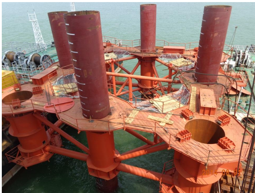
图 2.3.4-2 工艺定位架示意图
