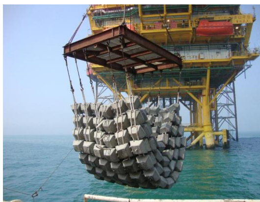
图 2.3.6-9 水泥压块保护示意
