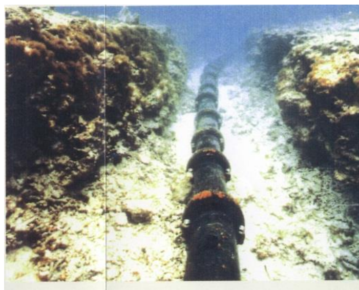
图 2.3.6-13 海缆保护套管示意图
